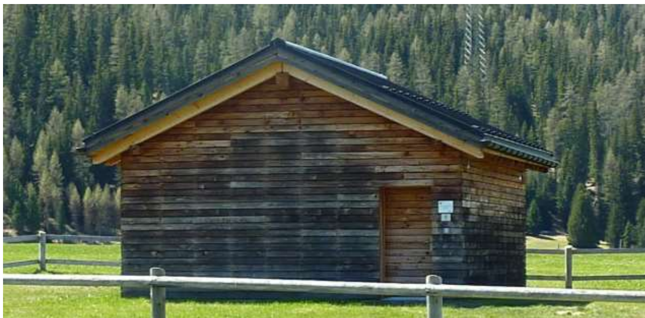
Stazione di pompaggio Seglias
